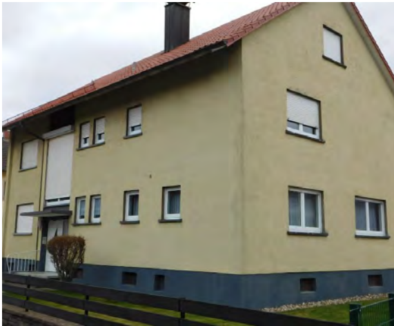
Abbildung 29: Beispiel für Gebäude mit neuen Fenstern, neuem Dach und ungedämmter Außenwand
