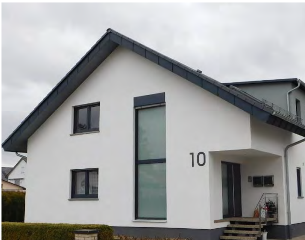
Abbildung 30: Beispiel für ein Gebäude mit ganzheitlicher Modernisierung der wärmeschutztechnischen Hülle
