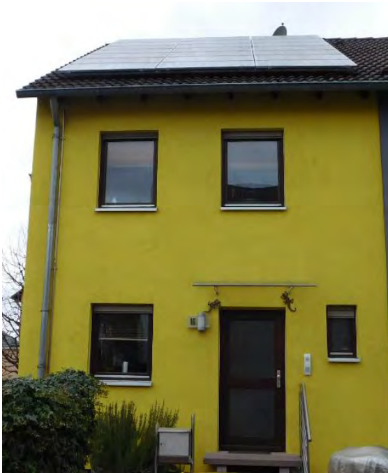
Abbildung 27: Beispiel für Gebäude mit neu gedämmter Außenwand und älteren Fenstern
